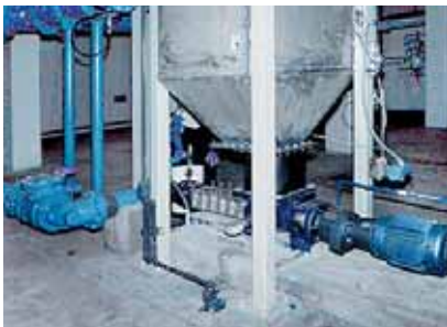
Насосы seerex BTQ 17-12. Продукт: механически сгущенный избыточный шлам примерно с 6% сухого остатка.
