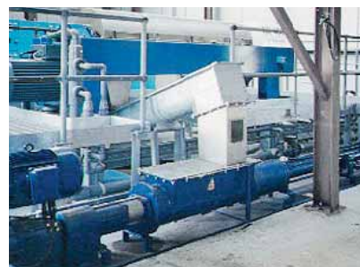
Насос seeper TENS 17-48. Продукт: обезвоженный шлам из центрифуги с 20 - 25% сухого остатка.
