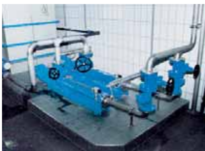
Насосы seeper BN 17-12 и BN 5-24. Продукт: сгущенный шлам в камерный фильтр-пресс.
