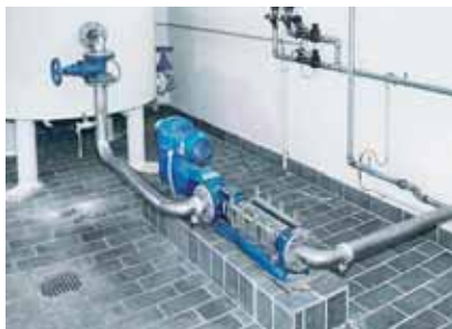
Насос seerex BN 10-6L . Продукт: известковое молоко. Особенность: Для увеличения срока службы смонтировано устройство для дополнительного натяжения статора
