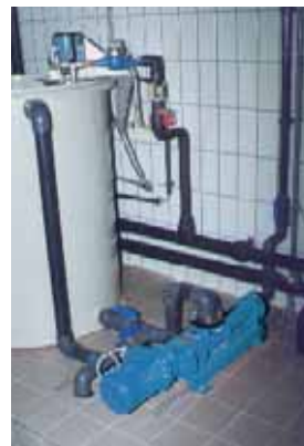
Насосы seepex BN 10-6L . Продукт: циркуляция концентрированного раствора флокулянта.
