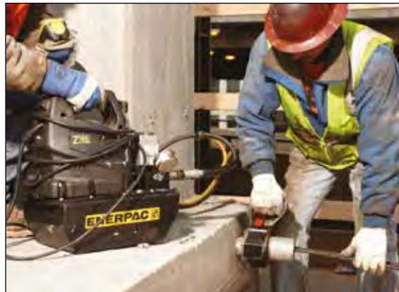
◀ Специально разработанные для тяжелых работ насосы серии ZU4 со стальным маслобаком можно безопасно эксплуатировать на современных строительных площадках.
