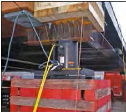
◀ Пример работы по ступенчатому подъему с применением выполненной на заказ подъемной системы Enerpac - подъем 360-тонного деревянного моста Akkerwinde в Нидерландах.
