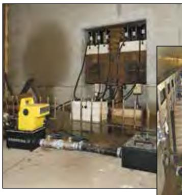
◀ Уникальные цилиндры RA-серии от Enerpac, малой массы, полностью сделанные из алюминиевого сплава – эти цилиндры RAC-506 идеально подошли для установки элементов тоннелей на дне рек. (строительство линий высокоскоростного ж/д сообщения в Голландии).
