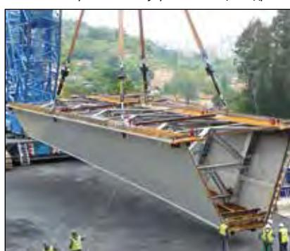
▼ Применение системы SyncHoist для постепенного подъема и позиционирования тяжелых стальных блоков секций надстройки корабля.
