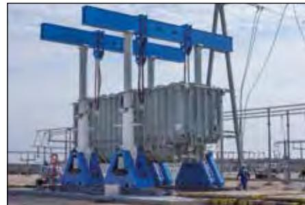
Подъем и позиционирование тяжелых грузов с высокой точностью
