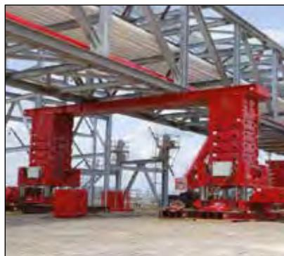
▼ Груз поднимают ступенчатым образом, постепенно поднимая и подкладывая под него новые опорные блоки, устанавливаемые один на другой и образующие в совокупности опорные стойки.
